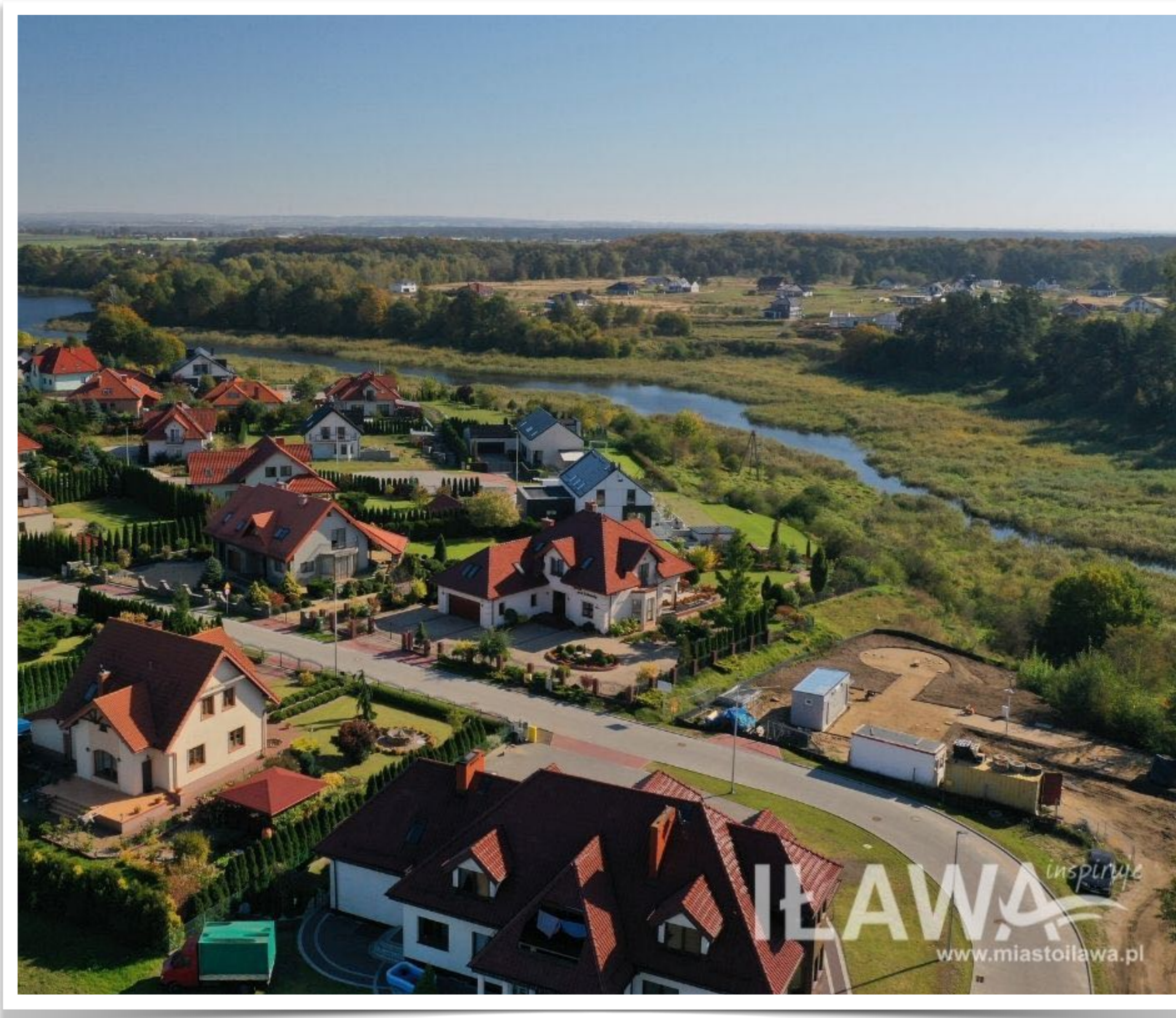
Budowa ul. Świerkowej i Sosnowej
