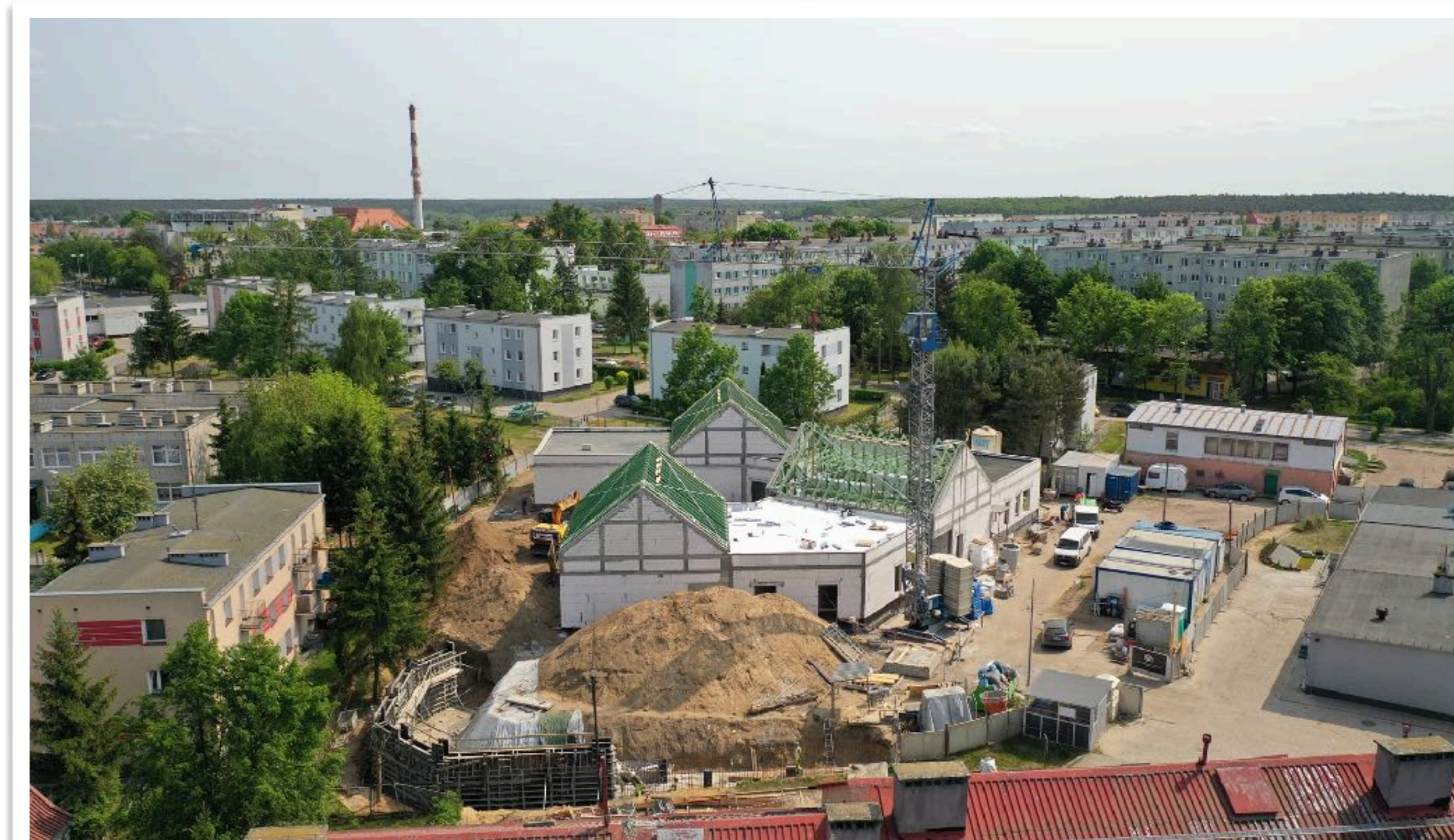
Budowa żłobka miejskiego na ul. 1 Maja.
