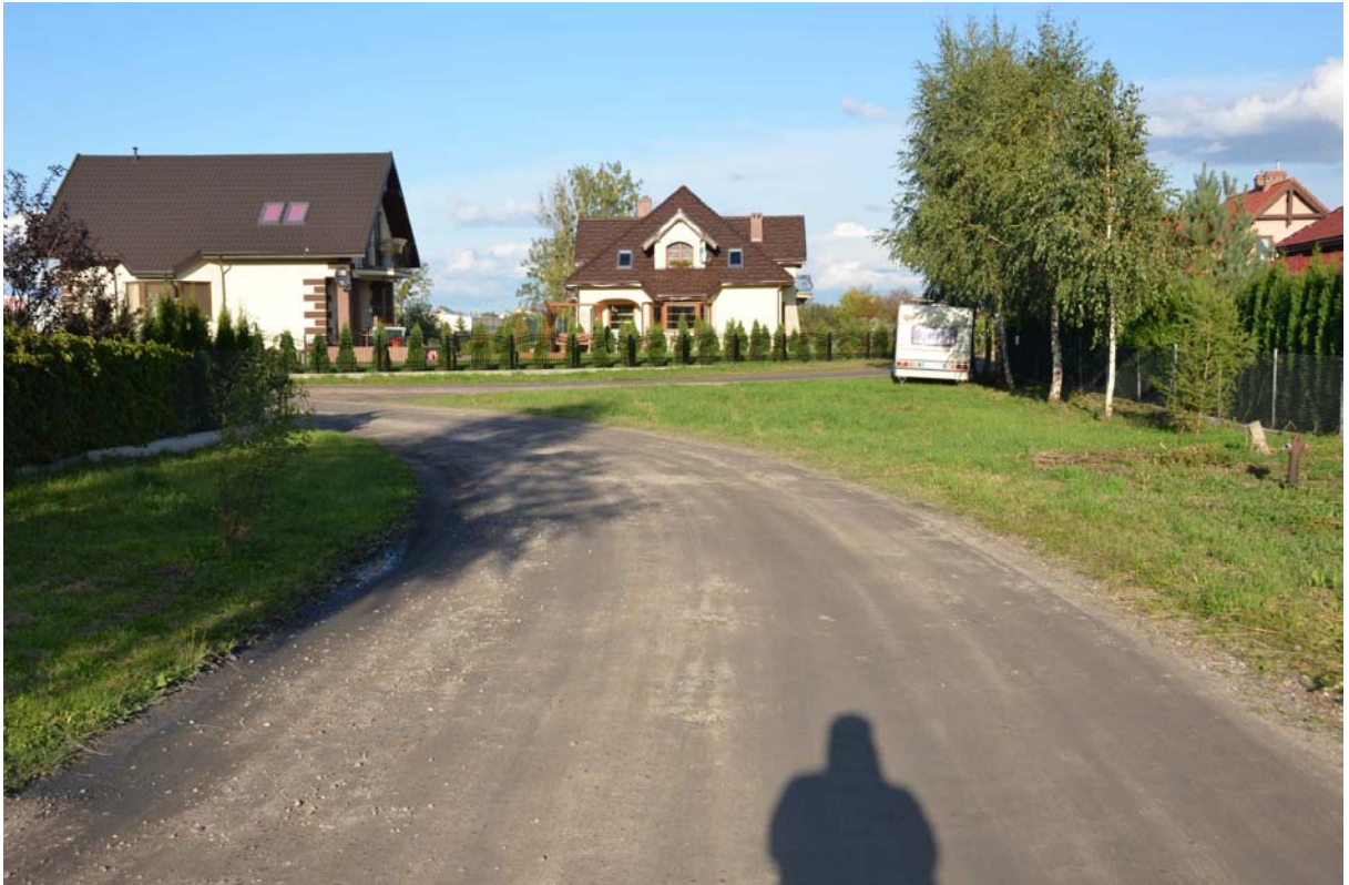
Fot. nr 2 teren przeznaczony pod lokalizację ronda – węzeł D
