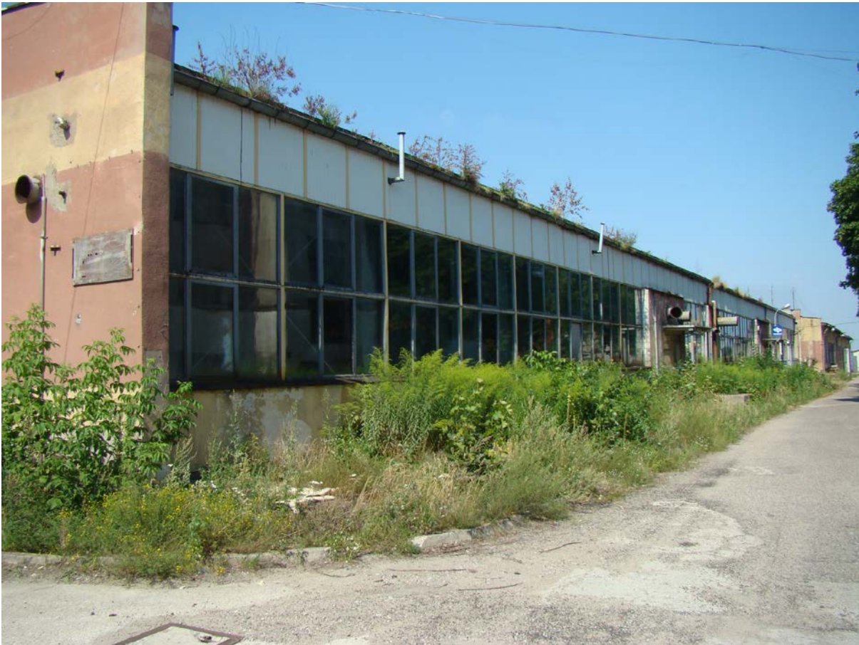
Widok na budynek nr 2 i 3
