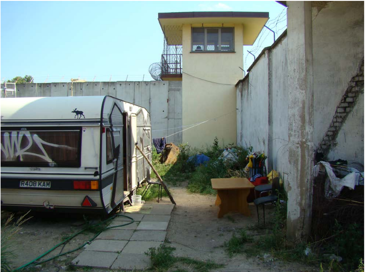
Widok na mur więzienny za bramą wjazdową do budynku nr 3 wraz z wieżyczką niepodlegającą rozbiórce
