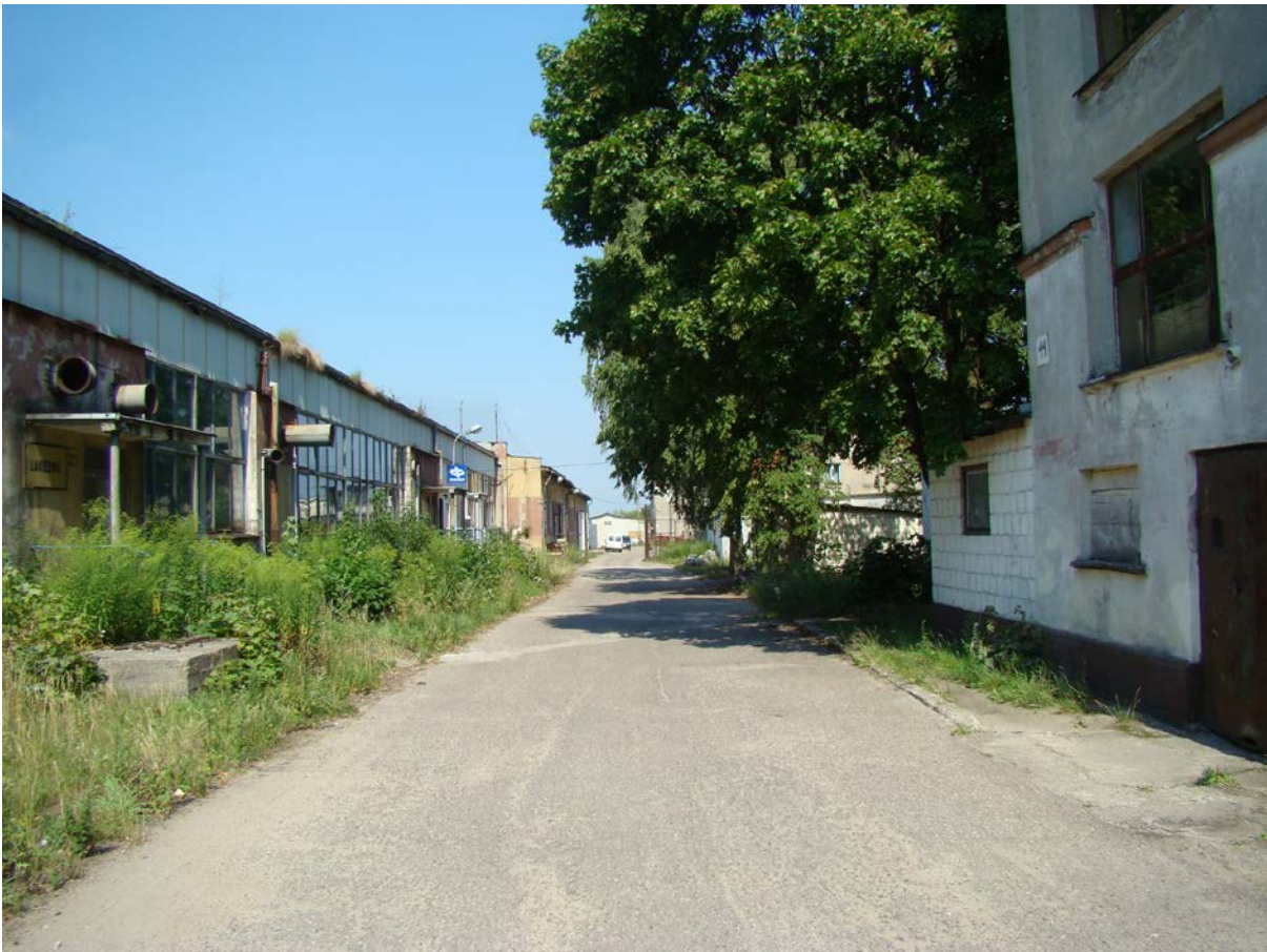
Przejazd między budynkiem nr 5 (część biurowa) i budynkiem nr 2
