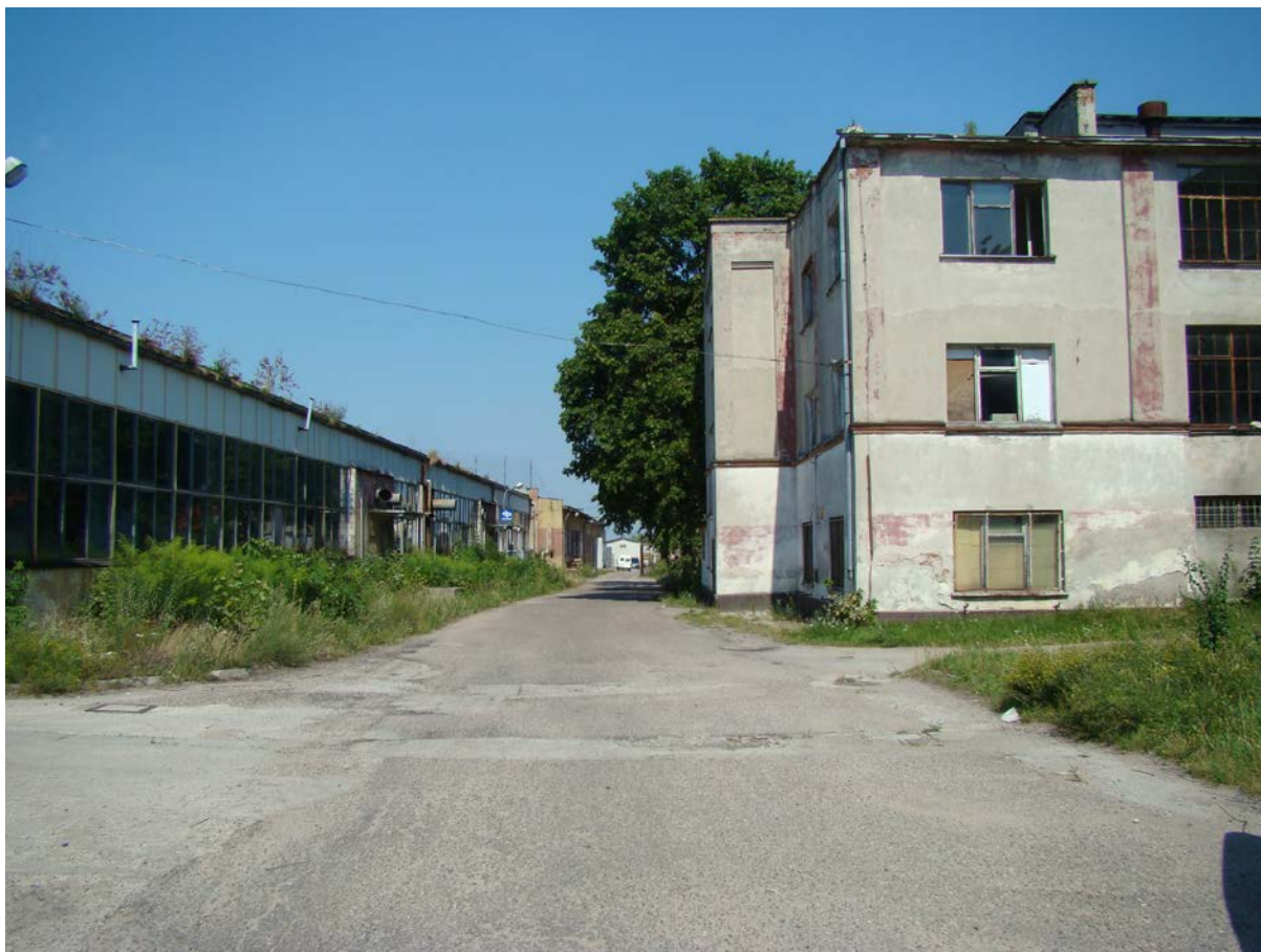
Budynek nr 5 część biurowa oraz budynek nr 2
