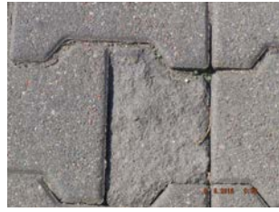
zaniżenie względem krawężnika , obrzeża poniżej 0,0 cm
