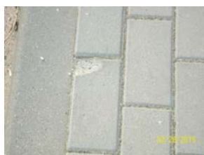
zaniżenie względem krawężnika , obrzeża poniżej 0,0 cm
