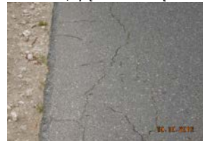
uszkodzona/spękania krawędź
