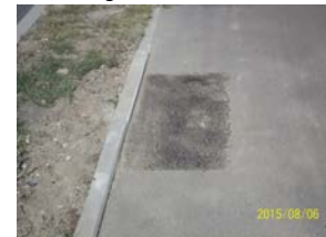
źle wykonana "łata" - niedowałowane , masa gruboziarnista
