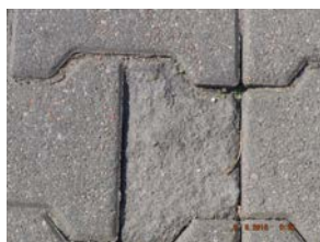
zaniżenie względem krawężnika , obrzeża poniżej 0,0 cm
