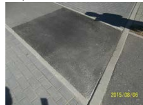
źle wykonana "łata" - niedowałowane , masa gruboziarnista
