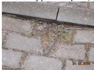
zaniżenie względem krawężnika , obrzeża poniżej 0,0 cm
