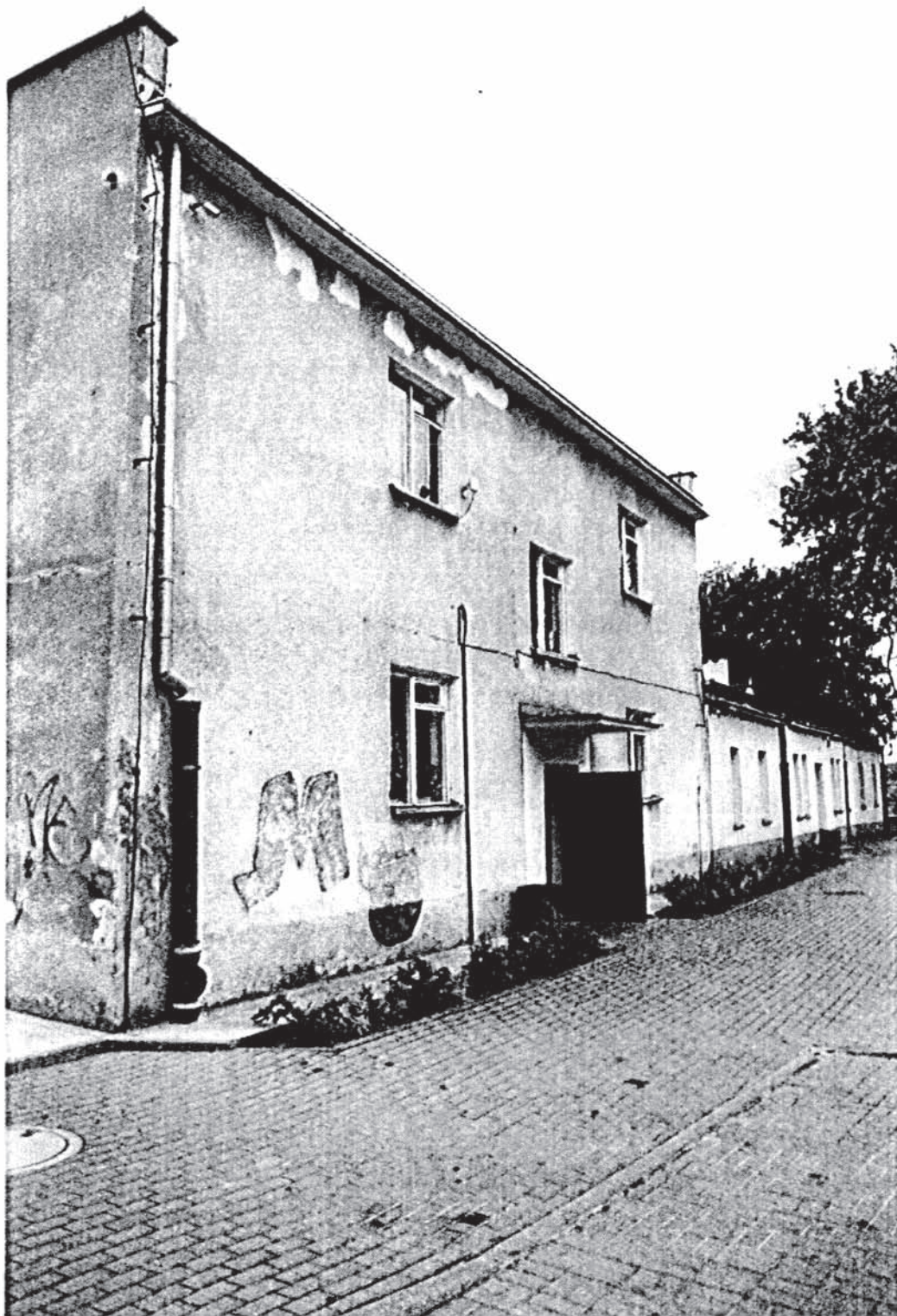
2. Budynek świetlicy i sali gimnastycznej – widok elewacji frontowych.
