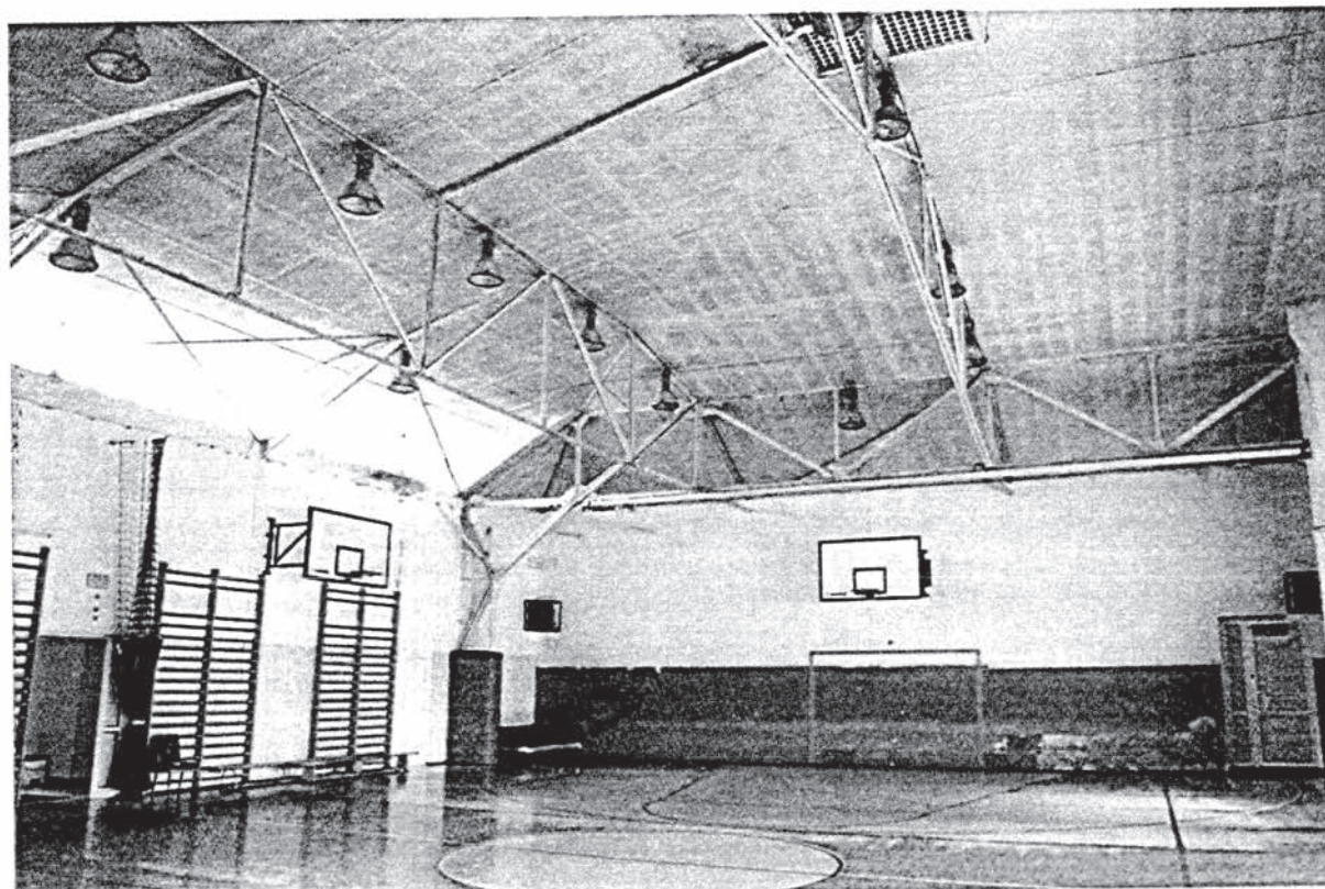
4. Budynek sali gimnastycznej – widok sali sportowej.
