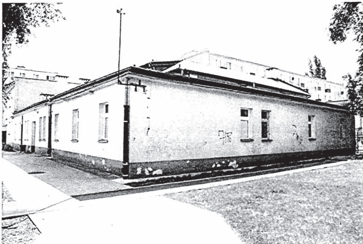
1. Budynek sali gimnastycznej- widok od strony pomieszczeń pomocniczych.
