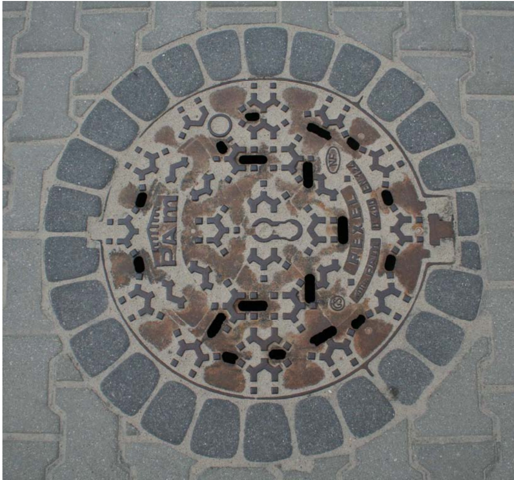
Fot. nr 5 Wykończenie nawierzchni jezdni w obrębie studni KD i KS
