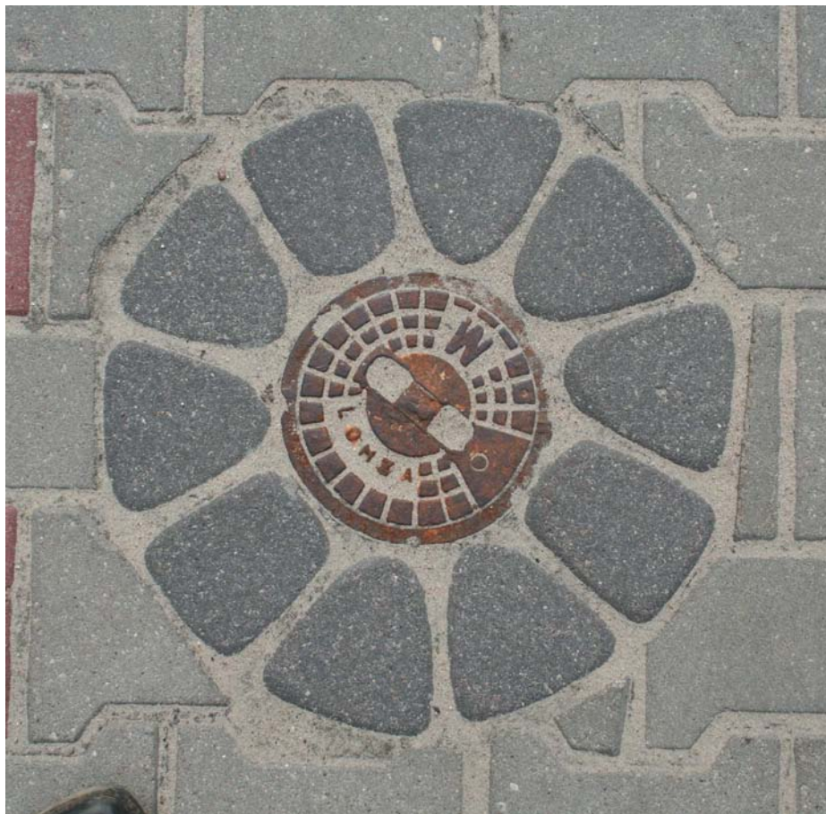
Fot. nr 7 Wykończenie nawierzchni jezdni w obrębie zaworów wodociągowych
