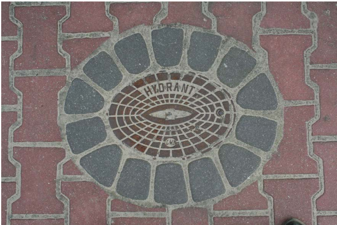
Fot. nr 6 Wykończenie nawierzchni jezdni w obrębie hydrantów podziemnych
