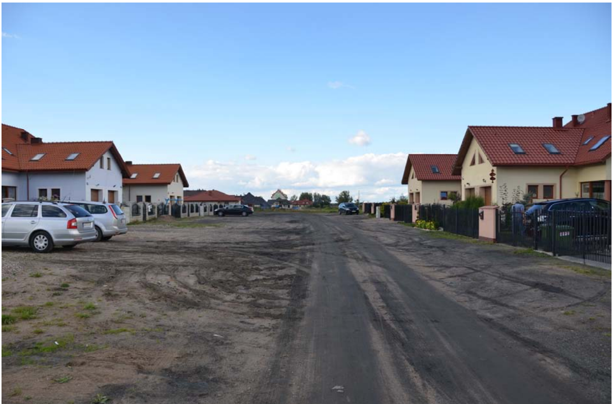
Fot. nr 4 Ulica Mieszka I
