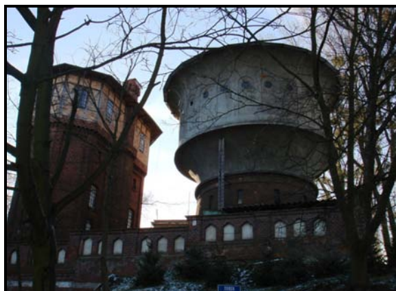
Rys.65. Wieża ciśnień przy ul. Dworcowej
