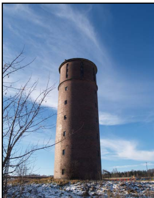
Rys.67. Wieża ciśnień przy ul. Kolejowej
