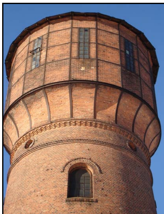
Rys.62. Wieża ciśnień przy ul. 1 Maja
