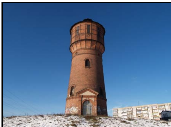
Rys.63. Wieża ciśnień przy ul. 1 Maja
