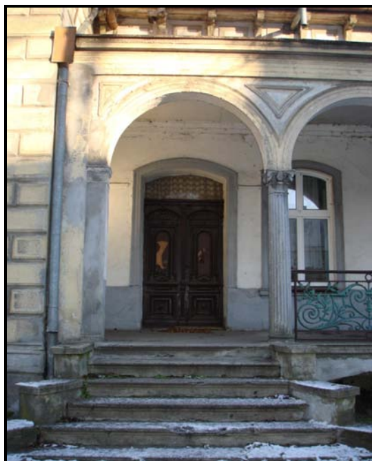
Rys.39. Wejście do kamienicy
