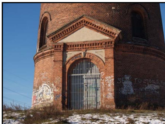
Rys.64. Wieża ciśnień przy ul. 1 Maja
