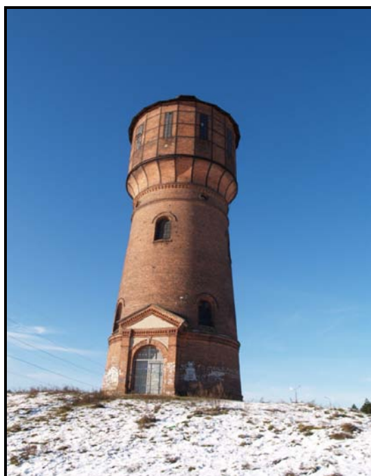
Rys.61. Wieża ciśnień przy ul. 1 Maja
