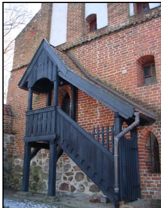
Rys. 6 Schody w kościele p.w. Przemienienia Pańskiego
