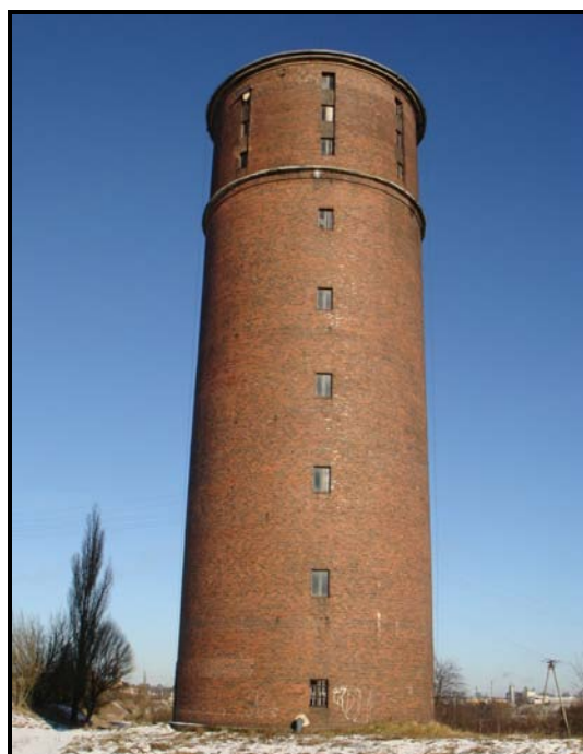
Rys.68. Wieża ciśnień przy ul. Kolejowej
