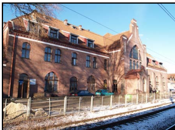
Rys.19. Dworzec od strony peronów
