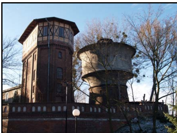
Rys.66. Wieża ciśnień przy ul. Dworcowej
