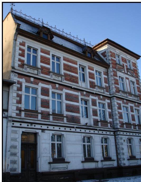
Rys.32 Kamienica przy ul. Kościuszki 14
