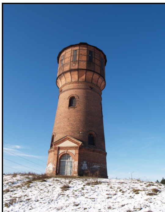
Rys.61. Wieża ciśnień przy ul. 1 Maja
