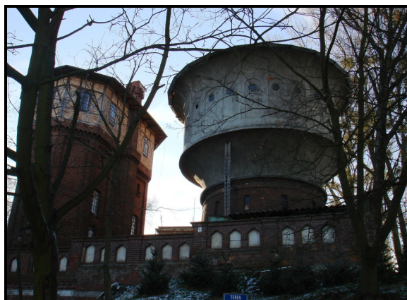
Rys.65. Wieża ciśnień przy ul. Dworcowej
