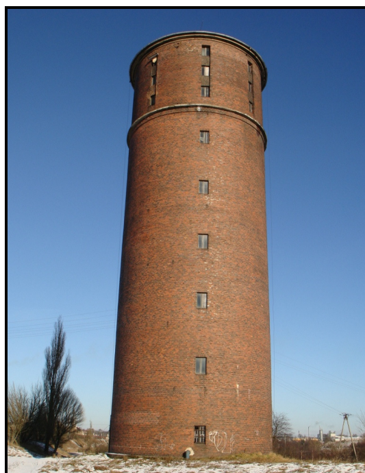
Rys.68. Wieża ciśnień przy ul. Kolejowej
