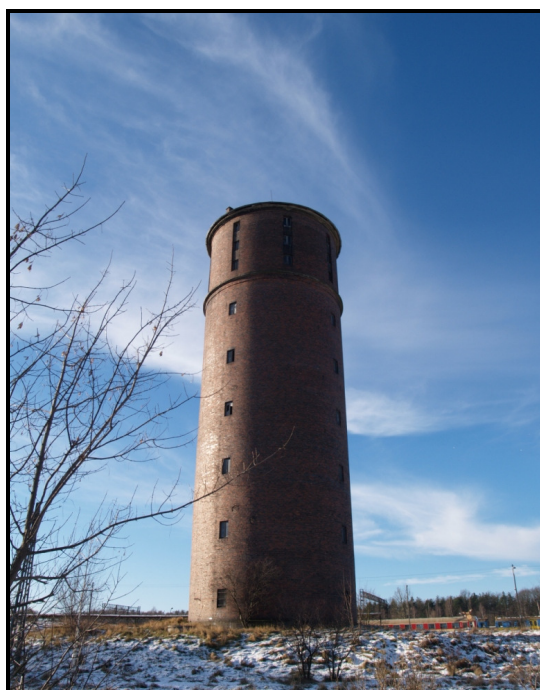
Rys.67. Wieża ciśnień przy ul. Kolejowej
