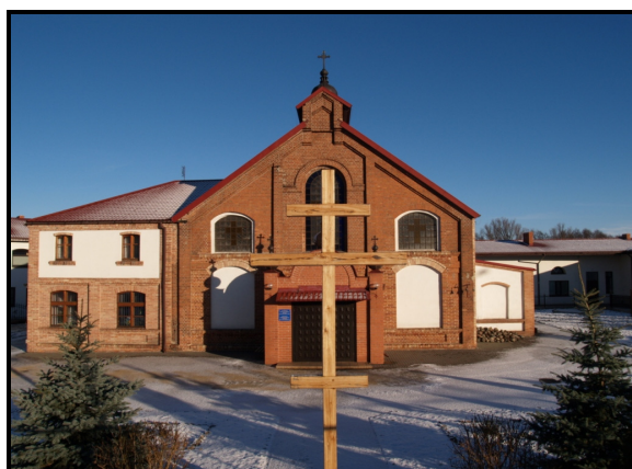
Rys.57. Gazownia (obecnie cerkiew)
