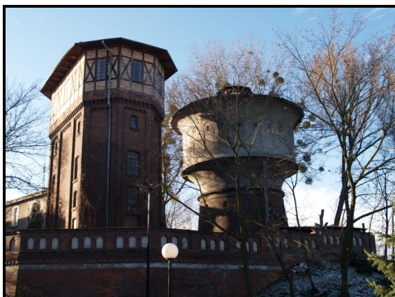
Rys.66. Wieża ciśnień przy ul. Dworcowej
