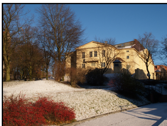
Rys.48. Hala miejska od strony jeziora
