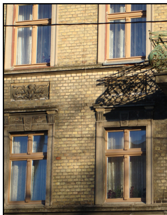
Rys.36. Kamienica przy ul. Kościuszki 15
