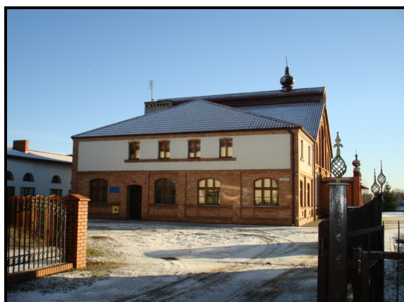
Rys.60. Gazownia (obecnie cerkiew)
