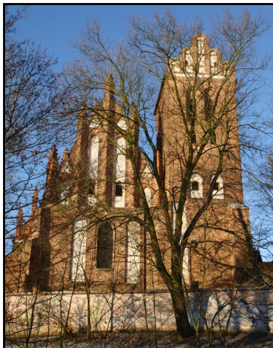
Rys. 5. Kościół p.w. Przemienienia Pańskiego (od strony ratusza)
