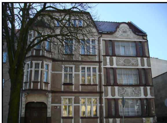
Rys.25. Kamienica przy ul. Kościuszki 6
