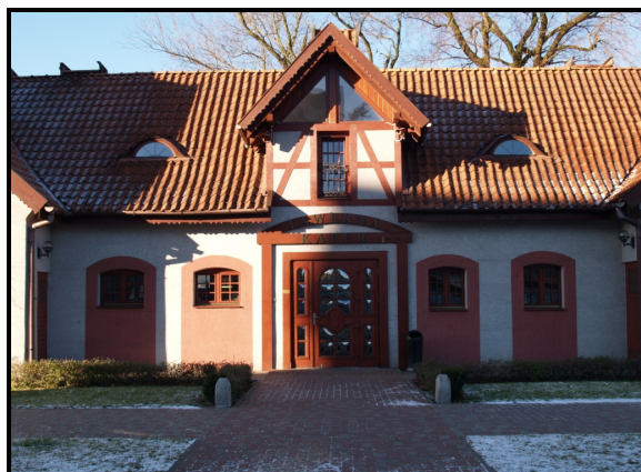
Rys.53. Obecny wygląd stajni-wozowni (tawerna „Kaper”)
