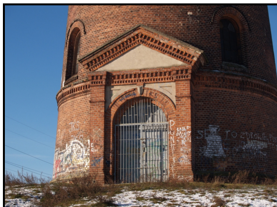
Rys.64. Wieża ciśnień przy ul. 1 Maja
