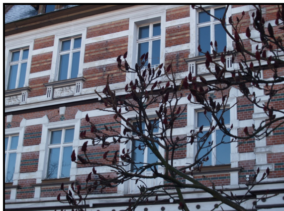
Rys.30. Kamienica przy ul. Kościuszki 14
