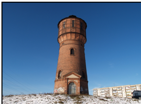
Rys.63. Wieża ciśnień przy ul. 1 Maja
