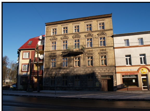
Rys.33. Kamienica przy ul. Kościuszki 15
