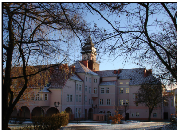
Rys.13. Ratusz od strony kościoła p.w. Przemienienia Pańskiego
