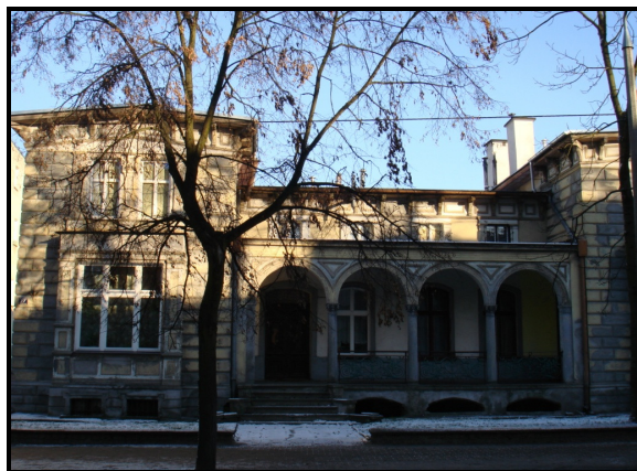
Rys.37. Kamienica przy ul. Kościuszki 27
