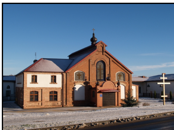
Rys.58. Gazownia (obecnie cerkiew)
