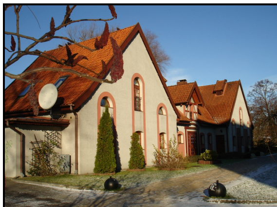
Rys.54. Obecny wygląd stajni-wozowni (tawerna „Kaper”)
