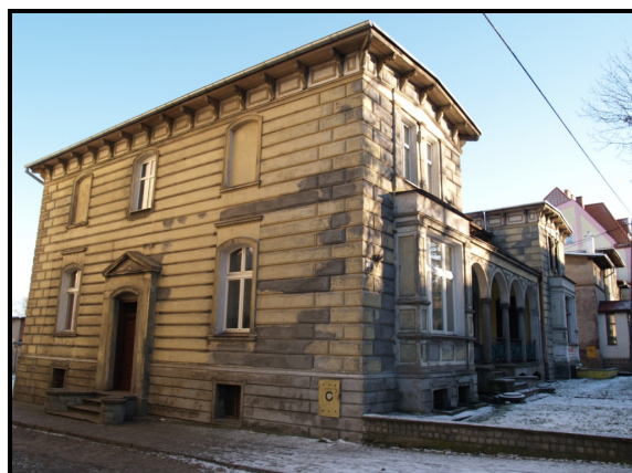
Rys.40. Kamienica przy ul. Kościuszki 27
