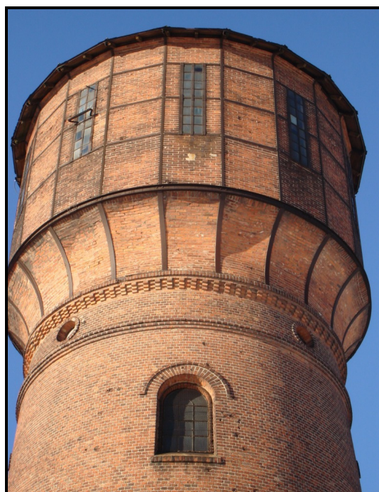
Rys.62. Wieża ciśnień przy ul. 1 Maja
