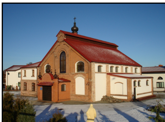
Rys.59. Gazownia (obecnie cerkiew)
