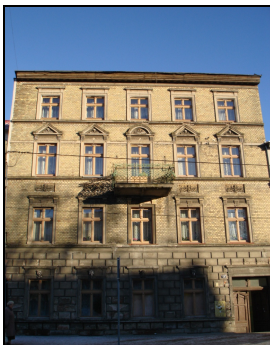
Rys.35. Kamienica przy ul. Kościuszki 15
