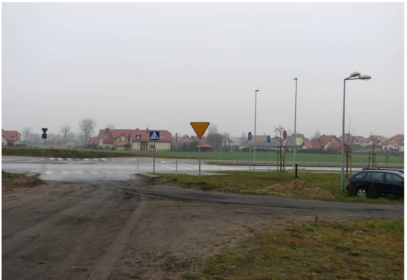
Fot.4. Widok na istniejące skrzyżowanie ul. Piastowskiej i Zielonej (wlot od strony ul. Zielonej)
