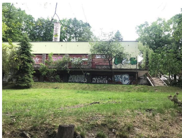
Zd. 6 Spacer badawczy (6 czerwca 2022) Widok na budynek Domu Weterana (źródło: A2P2)
