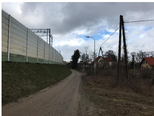
Zd. 15 Spacer badawczy (5 kwietnia 2022) Widok w ul. Jagiełły wzdłuż torów kolejowych (źródło: A2P2)
