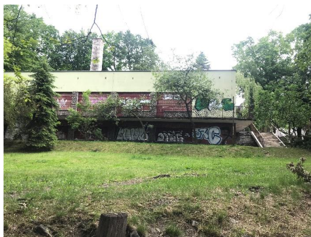
Zd. 6 Spacer badawczy (6 czerwca 2022) Widok na budynek Domu Weterana (źródło: A2P2)
