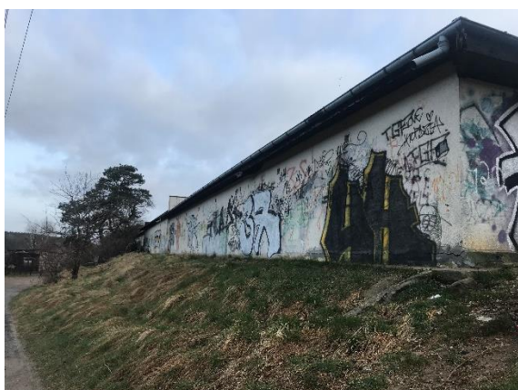
Zd. 7 Spacer badawczy (5 kwietnia 2022) Teren obok wieży ciśnień przy ul. 1-go Maja (źródło: A2P2)
