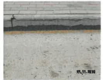
rozwarstwienie krawężnika
