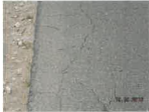
uszkodzona/spękania krawędź
