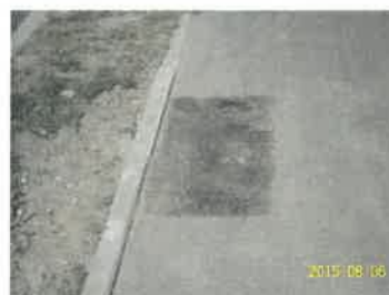
źle wykonana "łata" - niedowałowane , masa gruboziarnista
