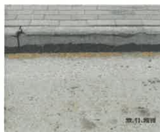
rozwarstwienie krawężnika
