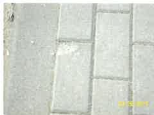
zaniżenie względem krawężnika , obrzeża poniżej 0,0 cm
