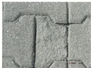
zaniżenie względem krawężnika , obrzeża poniżej 0,0 cm
