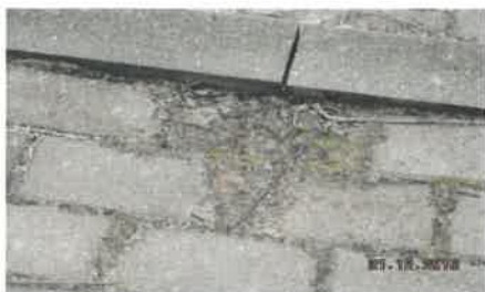
zaniżenie względem krawężnika , obrzeża poniżej 0,0 cm
