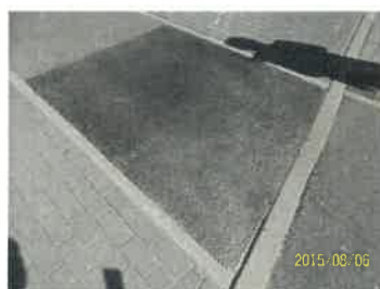
źle wykonana "łata" - niedowałowane , masa gruboziarnista
