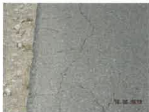
źle wykonana "łata" - niedowałowane , masa gruboziarnista
