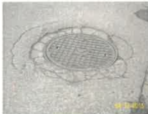
źle wykonana "łata" - niedowałowane , masa gruboziarnista
