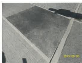
źle wykonana "łata" - niedowałowane , masa gruboziarnista
