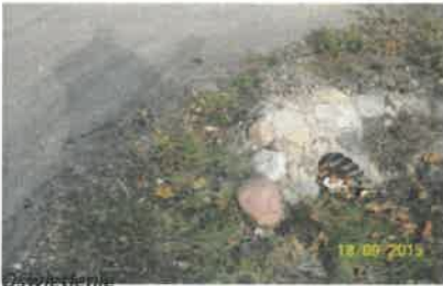
Przepusty - luźne kamienie zabruku do ponownego montażu
