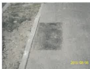
źle wykonana "łata" - niedowałowane , masa gruboziarnista
