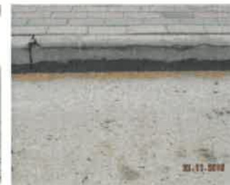
rozwarstwienie krawężnika
