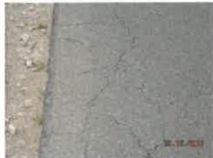
źle wykonana "łata" - niedowałowane , masa gruboziarnista
