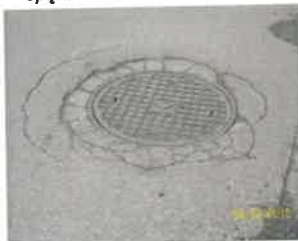
źle wykonana "łata" - niedowałowane, masa gruboziarnista
