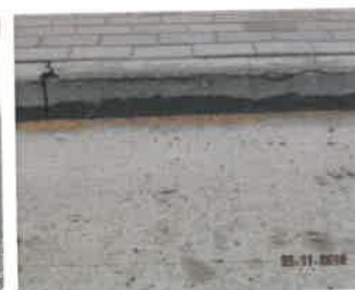
rozwarstwienie krawężnika
