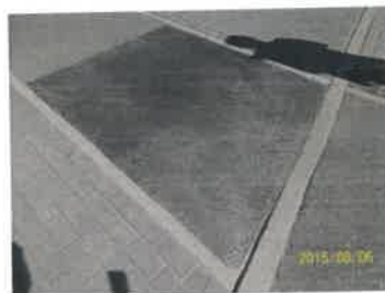
źle wykonana "łata" - niedowałowane, masa gruboziarnista
