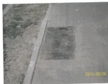
źle wykonana "łata" - niedowałowane, masa gruboziarnista
