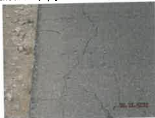
źle wykonana "łata" - niedowałowane, masa gruboziarnista
