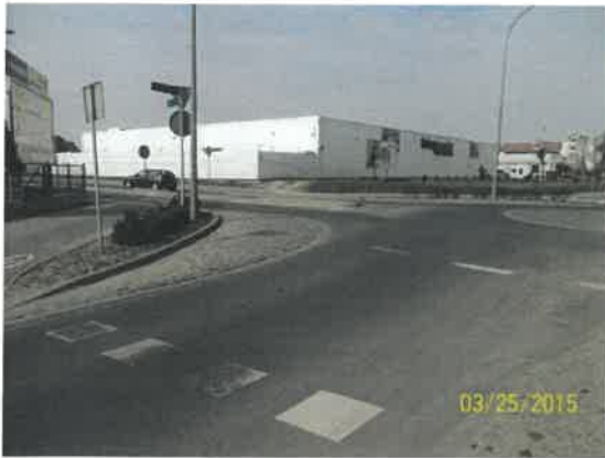
Skarpy, pobocza rozmycia do uzupełnienia
