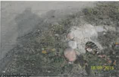
Przepusty - luźne kamienie zabruku do ponownego montażu
