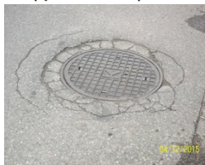
źle wykonana "łata" - niedowałowane , masa gruboziarnista
