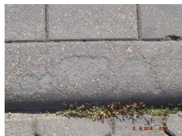
złuszczenia warstwy wykruszenia
