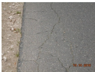
źle wykonana "łata" - niedowałowane , masa gruboziarnista
