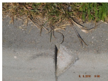
przytarcie walcem rozwarstwienie krawężnika
