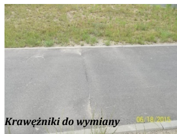
złuszczenia warstwy wykruszenia
