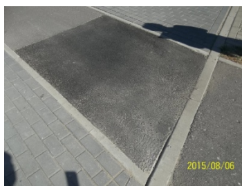
przytarcie walcem rozwarstwienie krawężnika
