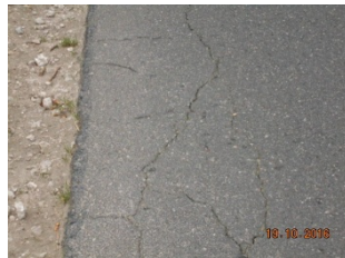
źle wykonana "łata" - niedowalowane, masa gruboziarnista
