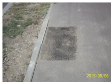
źle wykonana "łata" - niedowalowane, masa gruboziarnista
