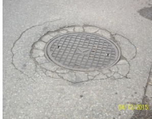
źle wykonana "łata" - niedowalowane, masa gruboziarnista
