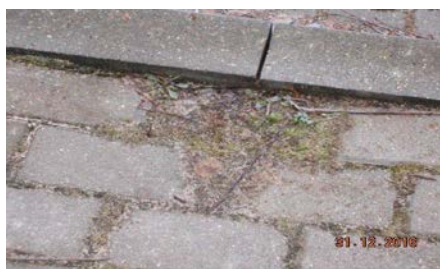
zaniżenie względem krawężnika , obrzeża poniżej 0,0 cm
