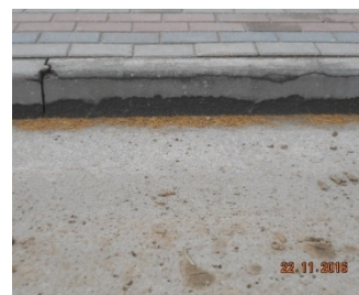
rozwarstwienie krawężnika
