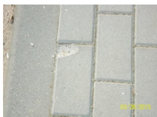
zaniżenie względem krawężnika , obrzeża poniżej 0,0 cm
