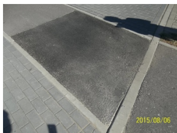
źle wykonana "łata" - niedowalowane, masa gruboziarnista
