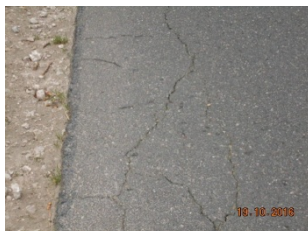
źle wykonana "łata" - niedowalowane, masa gruboziarnista
