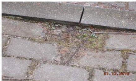
zaniżenie względem krawężnika, obrzeża poniżej 0,0 cm
