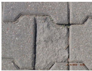
zaniżenie względem krawężnika, obrzeża poniżej 0,0 cm
