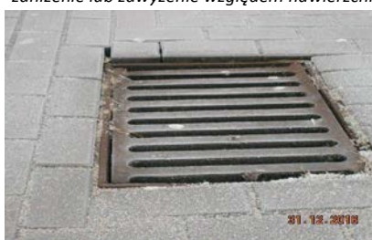
zaniżenie lub zawyżenie względem nawierzchni o 0,5 cm do regulacji
