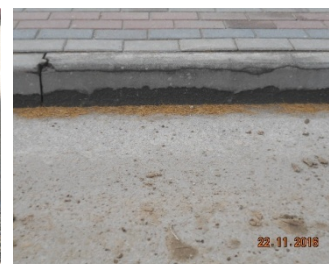
rozwarstwienie krawężnika
