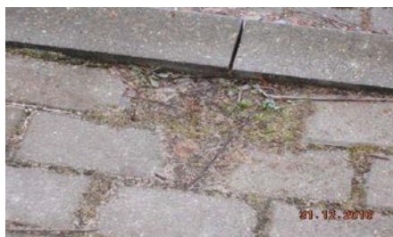
zaniżenie względem krawężnika , obrzeża poniżej 0,0 cm
