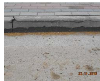
rozwarstwienie krawężnika
