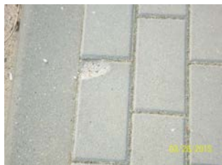
zaniżenie względem krawężnika , obrzeża poniżej 0,0 cm
