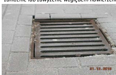
Kratki ściekowe, pokrywy włazów zaniżenie lub zawyżenie względem nawierzchni o 0,5 cm do regulacji
