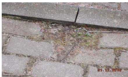
Krawężniki do wymiany
