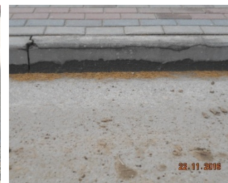
rozwarstwienie krawężnika
