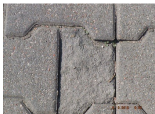
zaniżenie względem krawężnika, obrzeża poniżej 0,0 cm
