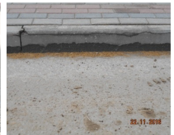
rozwarstwienie krawężnika
