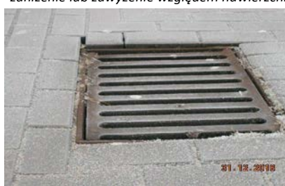
zaniżenie lub zawyżenie względem nawierzchni o 0,5 cm do regulacji
