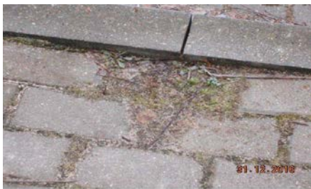
zaniżenie względem krawężnika, obrzeża poniżej 0,0 cm
