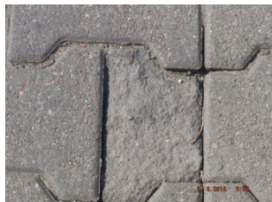
zaniżenie względem krawężnika , obrzeża poniżej 0,0 cm
