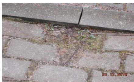
zaniżenie względem krawężnika , obrzeża poniżej 0,0 cm
