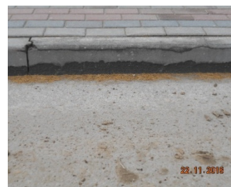
rozwarstwienie krawężnika
