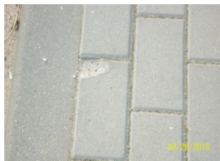
zaniżenie względem krawężnika , obrzeża poniżej 0,0 cm
