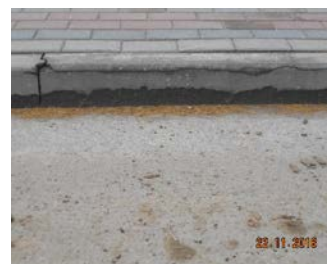
rozwarstwienie krawężnika
