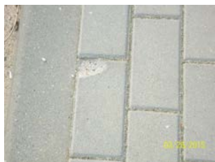
zaniżenie względem krawężnika , obrzeża poniżej 0,0 cm
