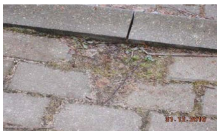
zaniżenie względem krawężnika , obrzeża poniżej 0,0 cm
