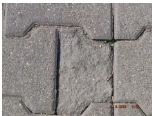
zaniżenie względem krawężnika , obrzeża poniżej 0,0 cm
