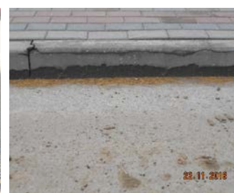
rozwarstwienie krawężnika
