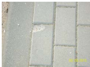
zaniżenie względem krawężnika , obrzeża poniżej 0,0 cm
