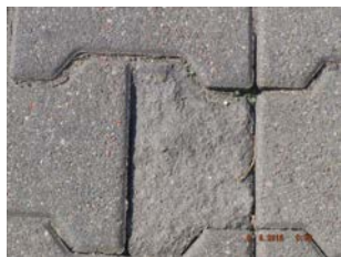
zaniżenie względem krawężnika , obrzeża poniżej 0,0 cm
