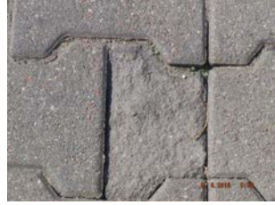
zaniżenie względem krawężnika , obrzeża poniżej 0,0 cm
