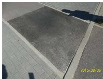
źle wykonana "łata" - niedowałowane , masa gruboziarnista
