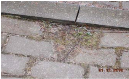
zaniżenie względem krawężnika , obrzeża poniżej 0,0 cm
