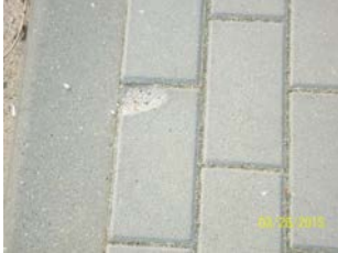
zaniżenie względem krawężnika , obrzeża poniżej 0,0 cm
