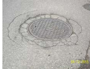
źle wykonana "łata" - niedowałowane , masa gruboziarnista
