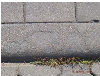
rozmycia do uzupełnienia
