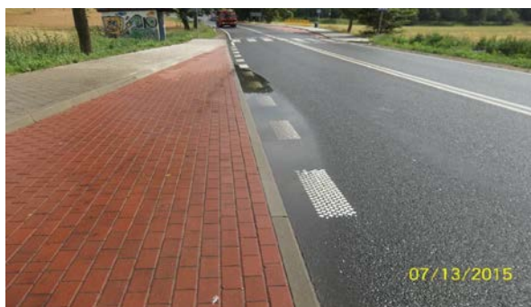
Ponowne malowanie gdy oznakowanie poziome widać w mniej niż 50 %, malowanie pojedynczych elementów
