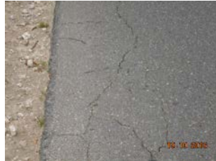
źle wykonana "łata" - niedowałowane , masa gruboziarnista
