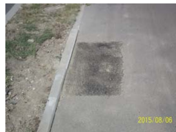
źle wykonana "łata" - niedowałowane , masa gruboziarnista
