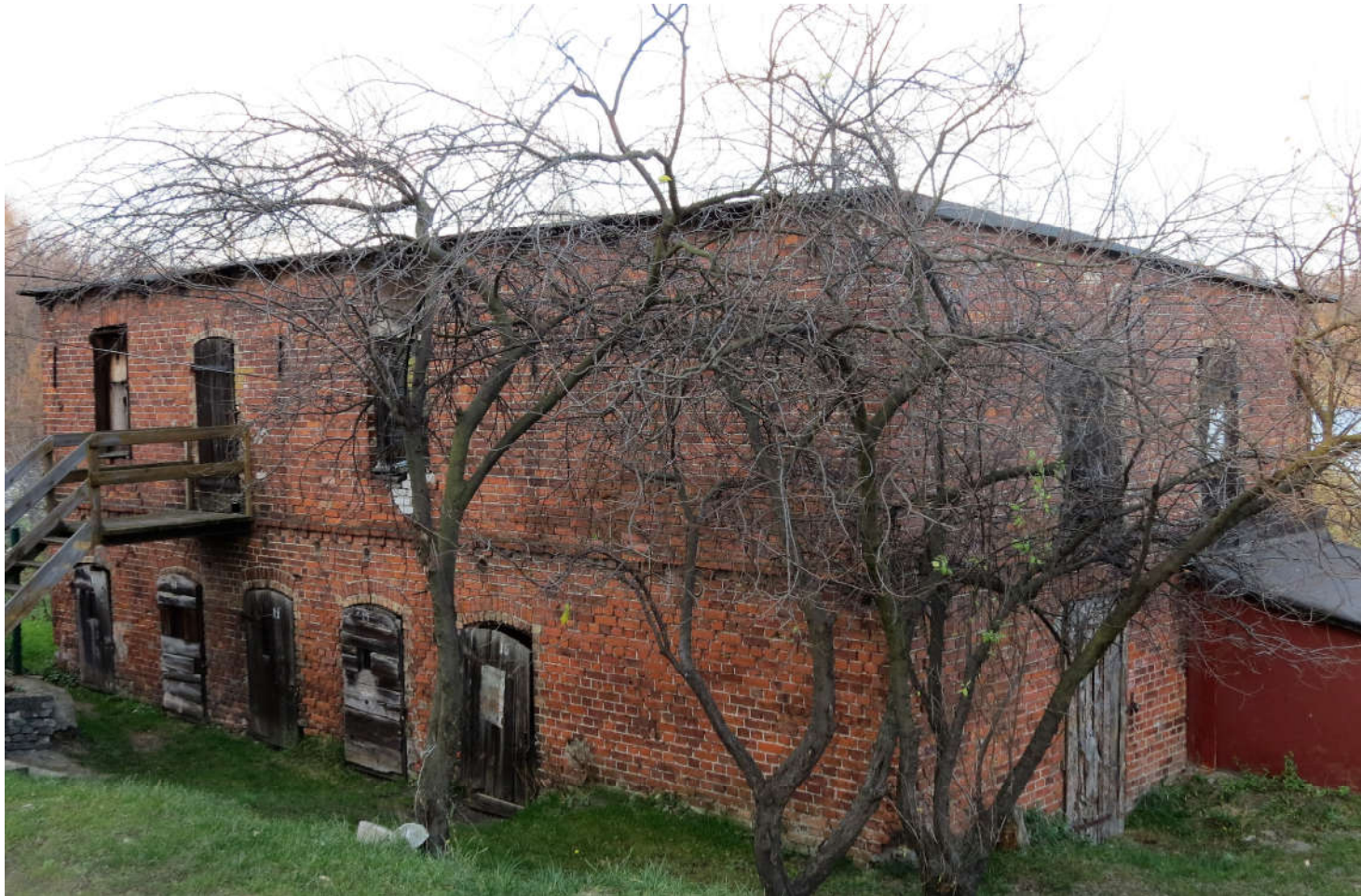
Widok ściany wzdłużnej i szczytowej z SW na NE
