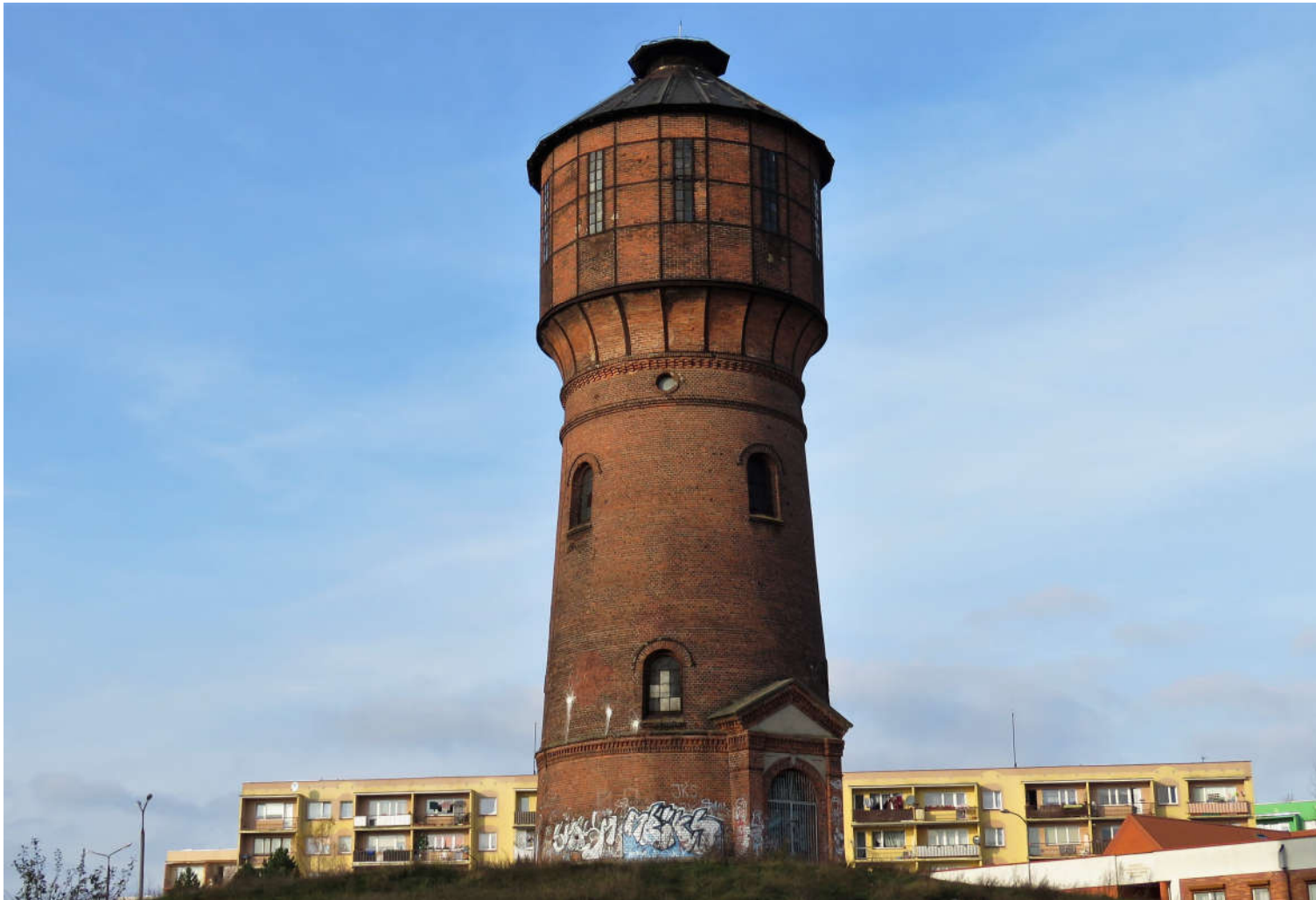
Widok wieży z SE na NW
