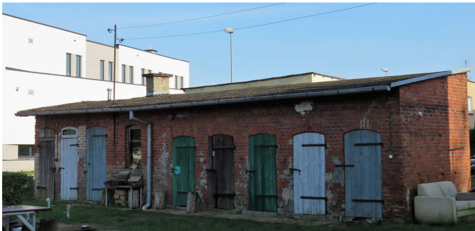
Widok ściany przedniej i szczytowej z SW na NE
