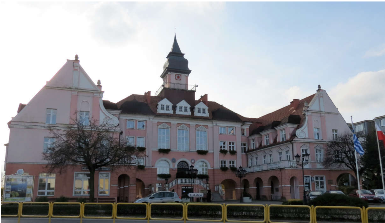
Widok fasady z N na S
