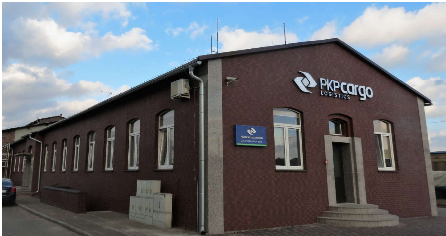
Widok ściany wzdłużnej i szczytowej z SW na NE
