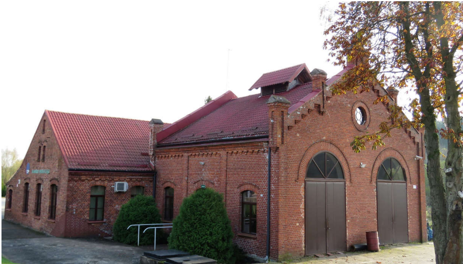
Widok bryły budynku z N na S
