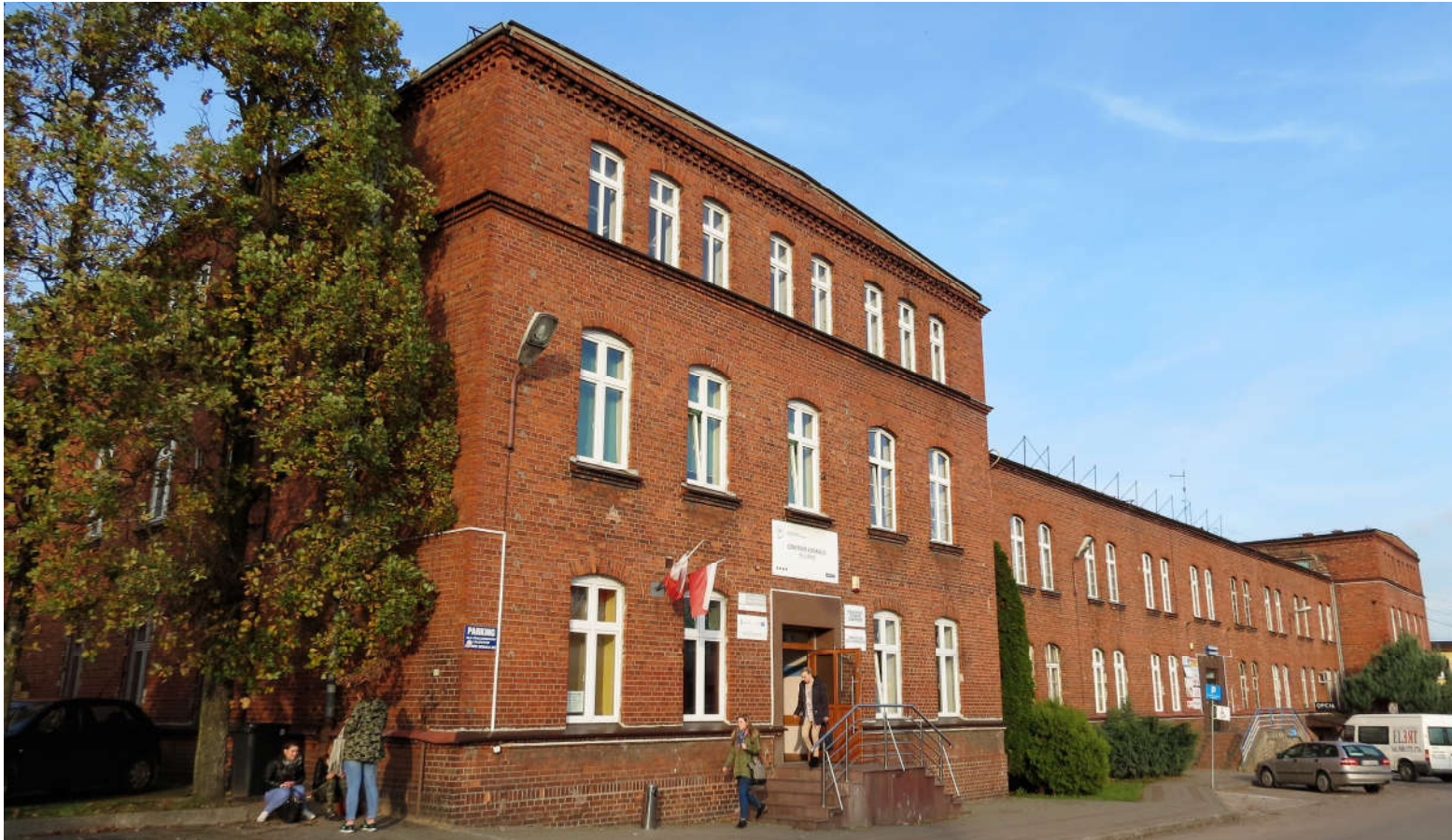
Widok ściany frontowej i szczytowej z SW na NE
