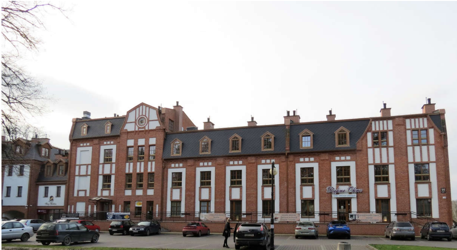
Widok ściany frontowej z E na W
