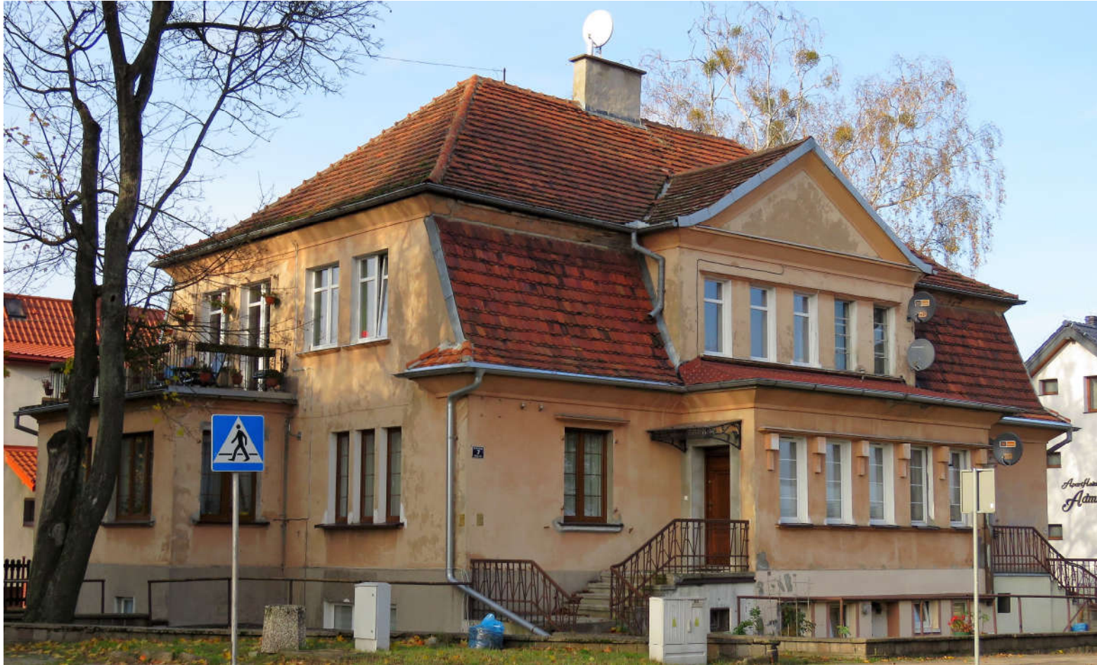
Widok ściany frontowej i szczytowej z SE na NW
