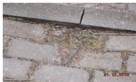
zaniżenie względem krawężnika, obrzeża poniżej 0,0 cm
