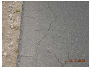
uszkodzona/spękania krawędź
