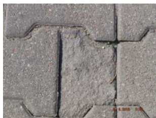
zaniżenie względem krawężnika, obrzeża poniżej 0,0 cm
