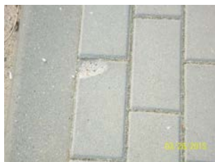
zaniżenie względem krawężnika, obrzeża poniżej 0,0 cm
