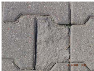
zaniżenie względem krawężnika , obrzeża poniżej 0,0 cm
