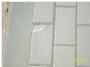
zaniżenie względem krawężnika , obrzeża poniżej 0,0 cm
