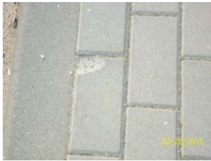
zaniżenie względem krawężnika , obrzeża poniżej 0,0 cm
