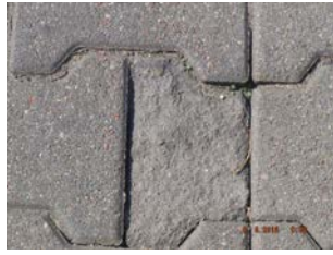
zaniżenie względem krawężnika , obrzeża poniżej 0,0 cm
