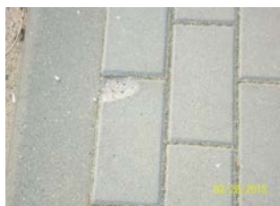
zaniżenie względem krawężnika , obrzeża poniżej 0,0 cm
