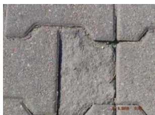
zaniżenie względem krawężnika , obrzeża poniżej 0,0 cm
