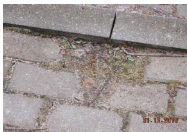
zaniżenie względem krawężnika , obrzeża poniżej 0,0 cm
