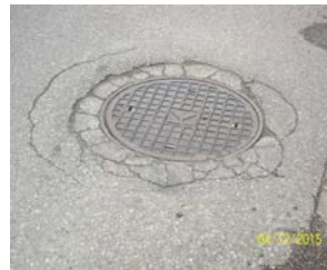
źle wykonana "łata" - niedowałowane , masa gruboziarnista
