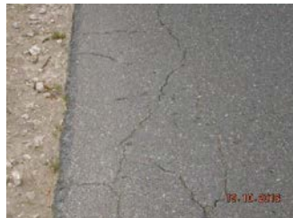
źle wykonana "łata" - niedowałowane , masa gruboziarnista
