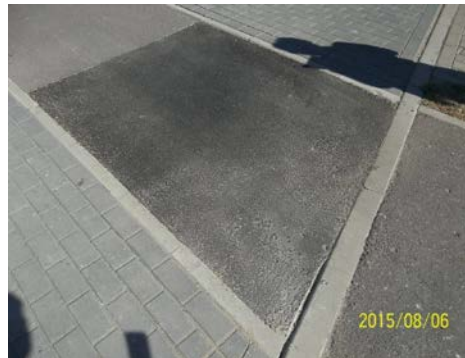
źle wykonana "łata" - niedowałowane , masa gruboziarnista
