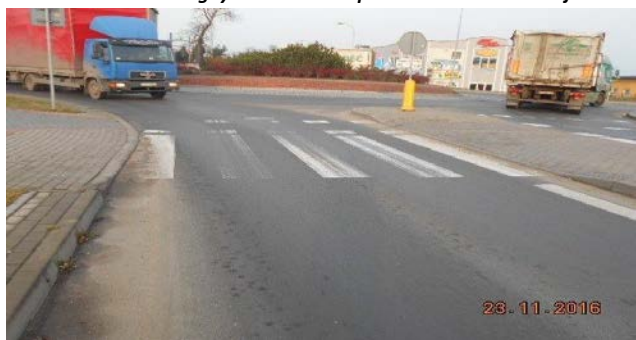
Oznakowanie poziome przetarte, gdy oznakowanie poziome widać powyżej 50 %
