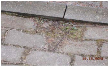
zaniżenie względem krawężnika , obrzeża poniżej 0,0 cm
