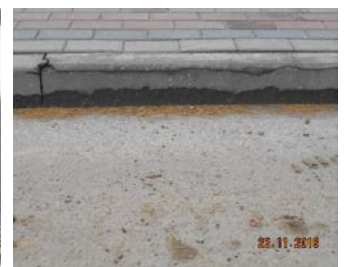
rozwarstwienie krawężnika
