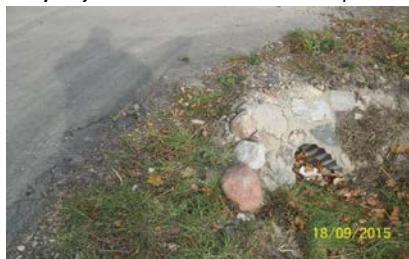
Przepusty - luźne kamienie zabruku do ponownego montażu
