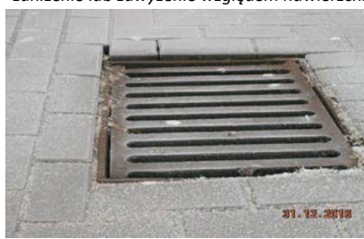
Kratki ściekowe , pokrywy włazów zaniżenie lub zawyżenie względem nawierzchni o 0,5 cm do regulacji
