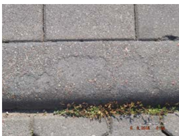
rozmycia do uzupełnienia
