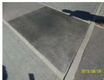
źle wykonana "łata" - niedowałowane , masa gruboziarnista
