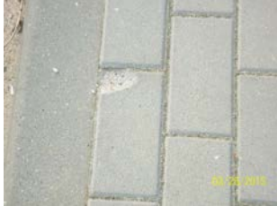
zaniżenie względem krawężnika , obrzeża poniżej 0,0 cm
