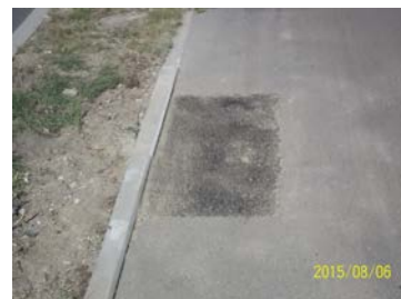
źle wykonana "łata" - niedowałowane , masa gruboziarnista
