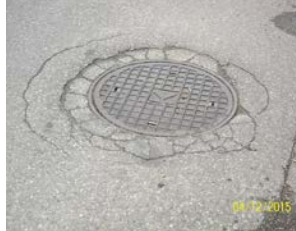
źle wykonana "łata" - niedowałowane , masa gruboziarnista
