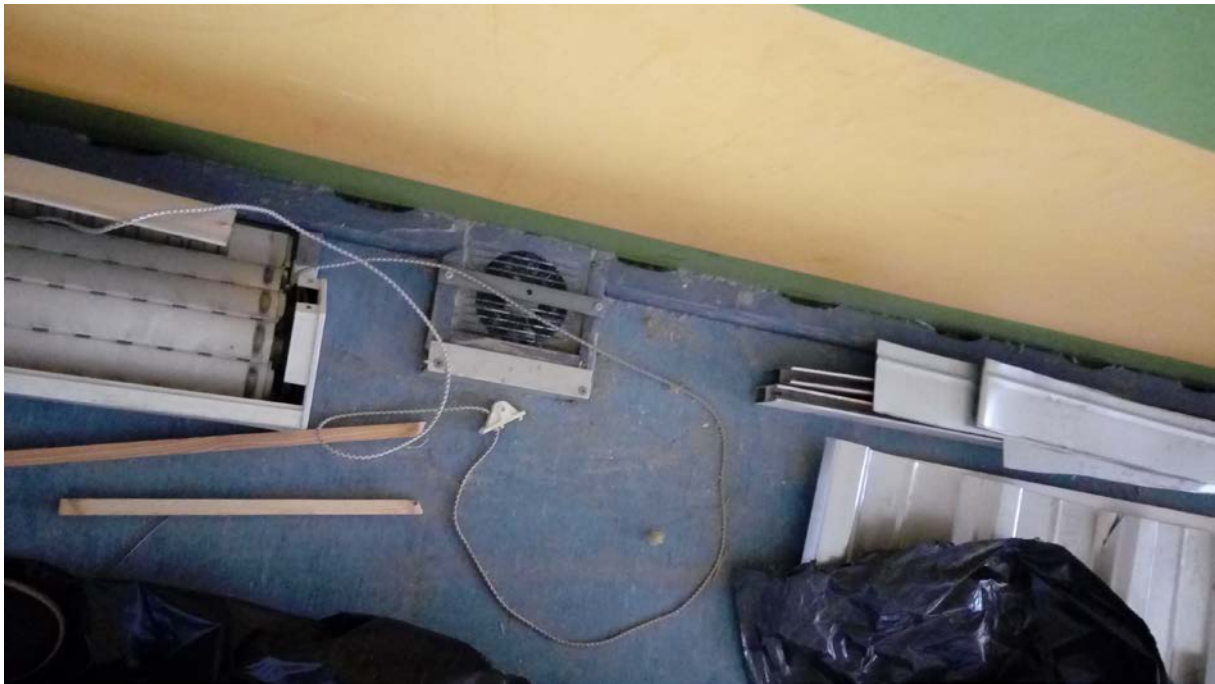
WENTYLATOR PODŁOGOWY ZAŁĄCZANY Z POM. TECHNICZNEGO NR 11
