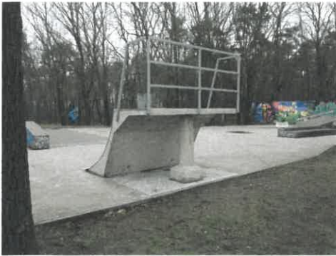
Rys. 1 – przeszkoda prefabrykowana z otwartymi ścianami bocznymi.
